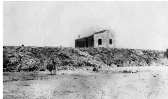
E faro aki a cende un lampi den un linea di aproximadamente trinta meter. E construccion di stal pa e lampi, spielnan tabatin mas o menos cincuenta pia halto. Den e periodo di 1965-1970 tabata usa gas acetylin y entre 1969-1970 a cambia pa coriente pa e lampi, unda a modernisa e mecanismo. Na e parti abou na e trapi tin algun coneccioanan di e botternan di gas di e tempo cu tabata usa gas acetylin.
